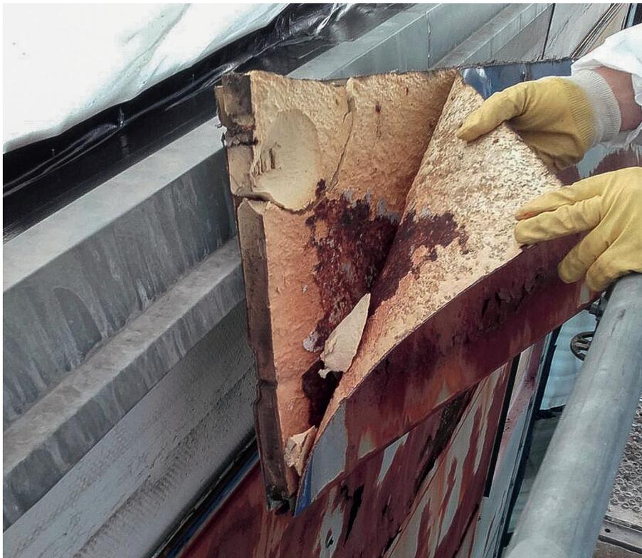
5. Berlin, UT2, Roststellen auf der Innenseite der Sandwichpaneel lösen das Blech vom inneren PU-Kern ab, 2016
